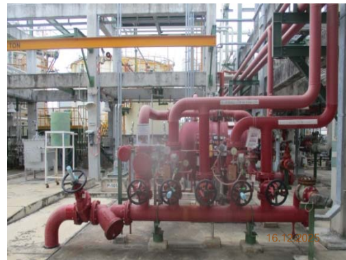
รูปที่ 50 ระบบโฟม (Foam System)
