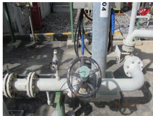
รูปที่ 74 Shut off Valve
