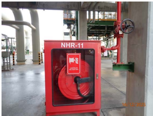
รูปที่ 49 Hydrant และ Hose box
