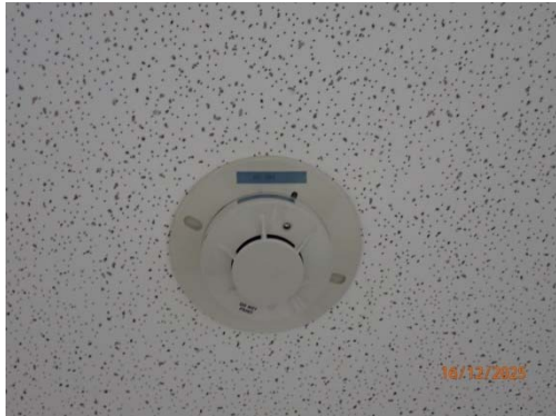
รูปที่ 53 Smoke Detector
