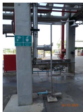
รูปที่ 44 อ่างล้างตาและร่างกายฉุกเฉิน
