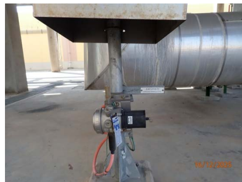
รูปที่ 52 Gas Detector
