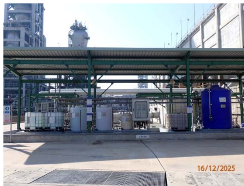
รูปที่ 46 ภาชนะจัดเก็บสารเคมีที่ปิดมิดชิด
