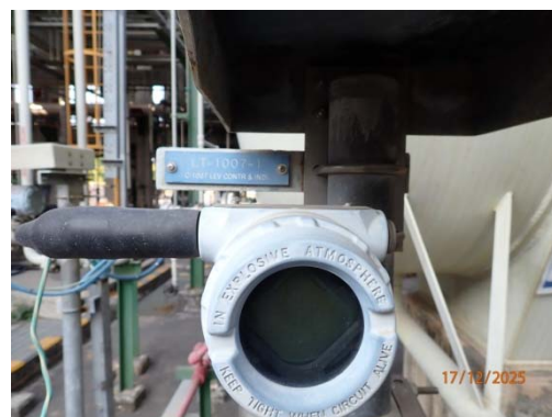
รูปที่ 70 อุปกรณ์วัดระดับของสารเคมีในถังเก็บ
